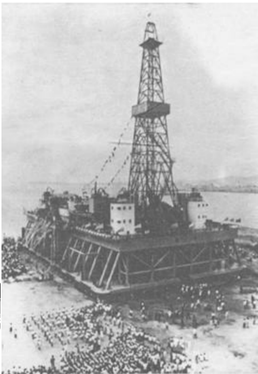
图为“胜利二号”钻井平台在青岛北海船厂海滩“步行”下水。
